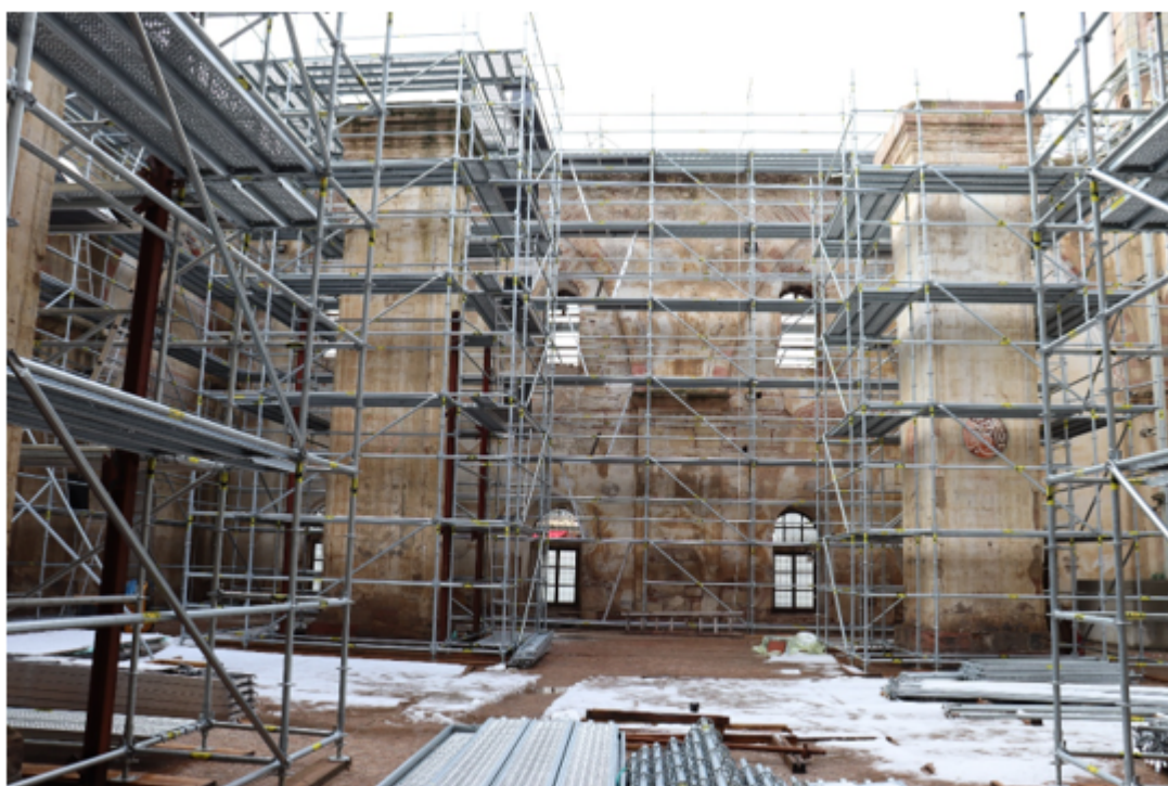
Εσωτερική όψη, πλευρά 2: πηγή: φωτ. αρχείο ΔΣΑΝΜ, 2025
