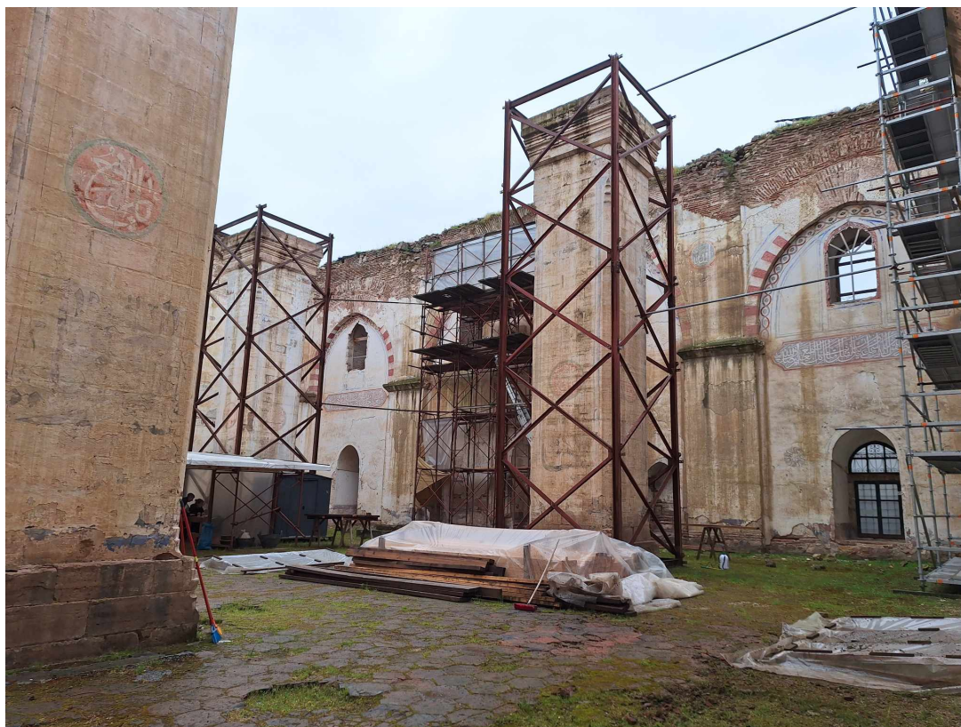
Εσωτερική όψη, άποψη πλευράς 3: πηγή:φωτ. αρχείο ΔΣΑΝΜ, 2024
