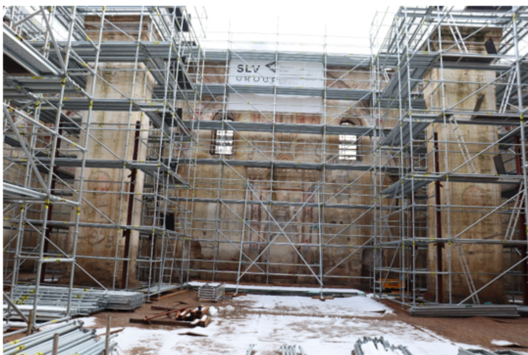
Εσωτερική όψη, πλευρά 3: πηγή: φωτ. αρχείο ΔΣΑΝΜ, 2025
