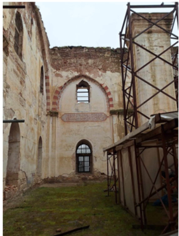
Εσωτερική όψη, άποψη πλευρών 3, 4 και πεσσού 3 : πηγή: φωτ. αρχείο ΔΣΑΝΜ, 2024
